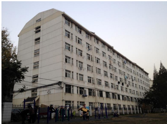
粉刷后的宿舍楼
